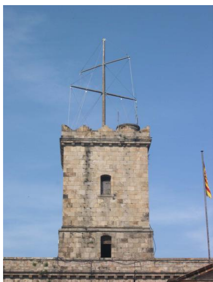
Torre del castell de Montjuïc
