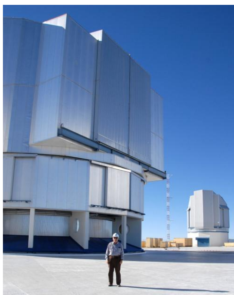
Un dels edificis que allotgen els telescopis principals. Notis la netedat del cel.
